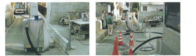
対象管きょに施工車両が近接できなくても、施工可能です。
